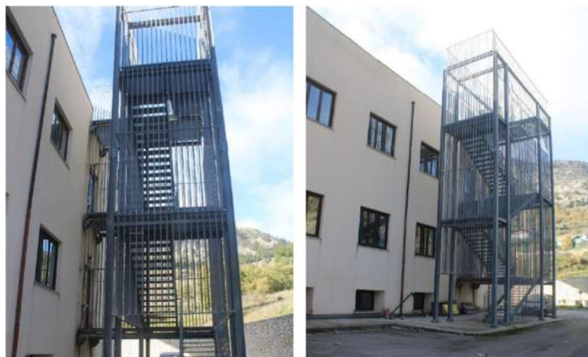
Scala metallica antincendio prospetto sul retro
